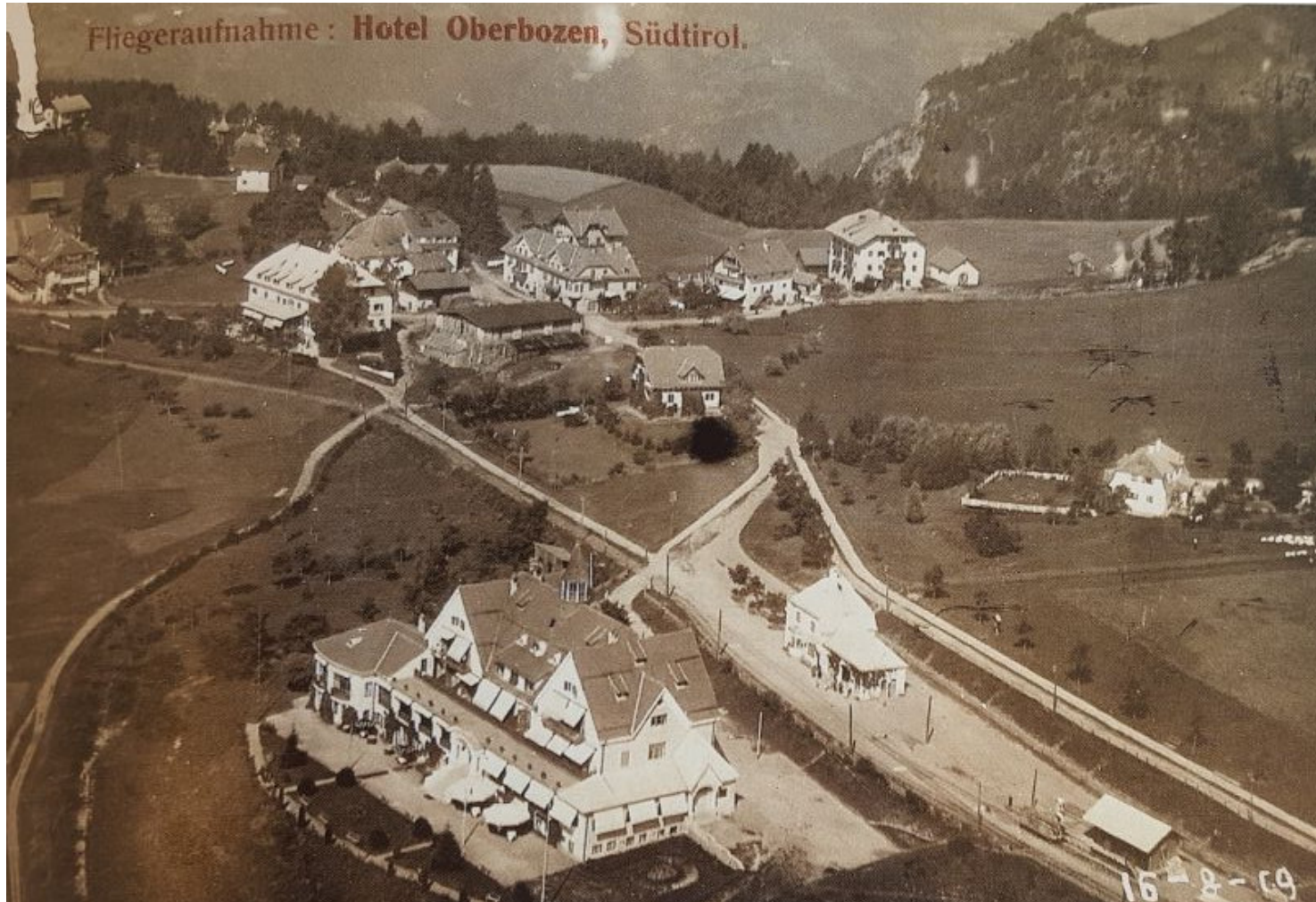
Bahnhof Oberbozen anno 1909 Foto: Archiv Hotel Holzner, Oberbozen
